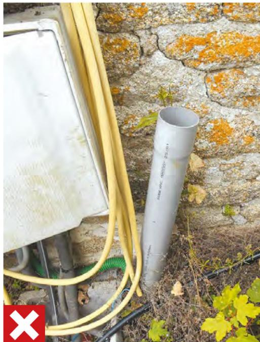
Evacuation inappropriée de l'air chargé en radon
