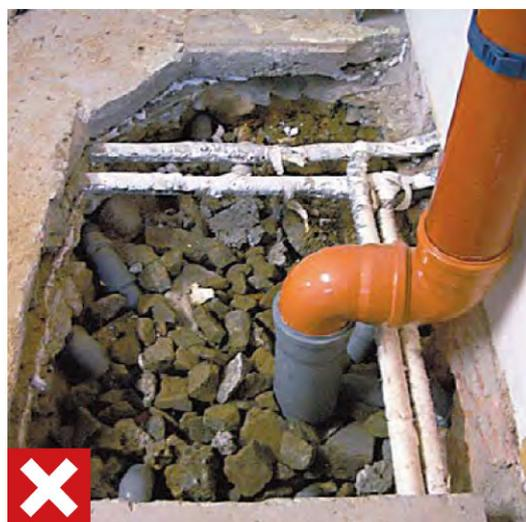
Mauvaise pratique : le passage de la conduite à travers la dalle n'est pas étanche ©CSTB
