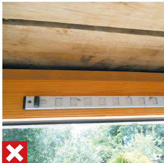
*L'absence, la fermeture ou le mauvais dimensionnement des bouches d'entrée d'air frais peut être responsable de l'accumulation de radon*
